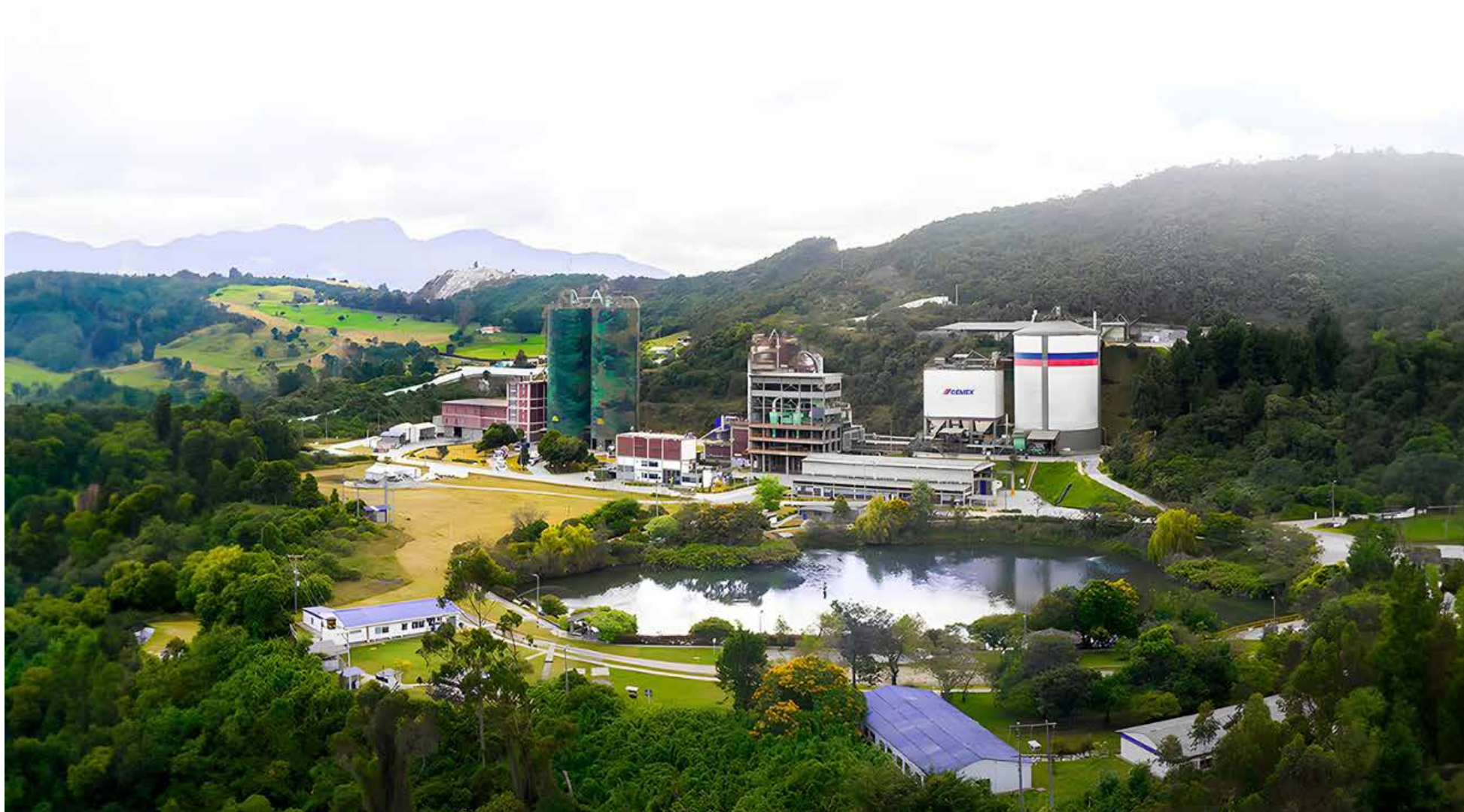
Planta Cemex Colombia, en Santa Rosa (La Calera, Cundinamarca)
